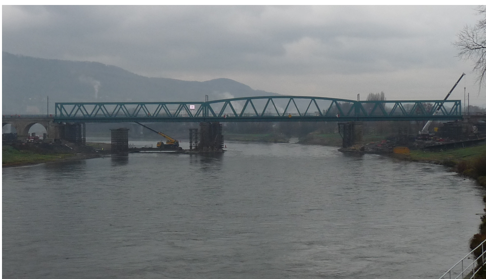
Těsně před dokončením stavby
